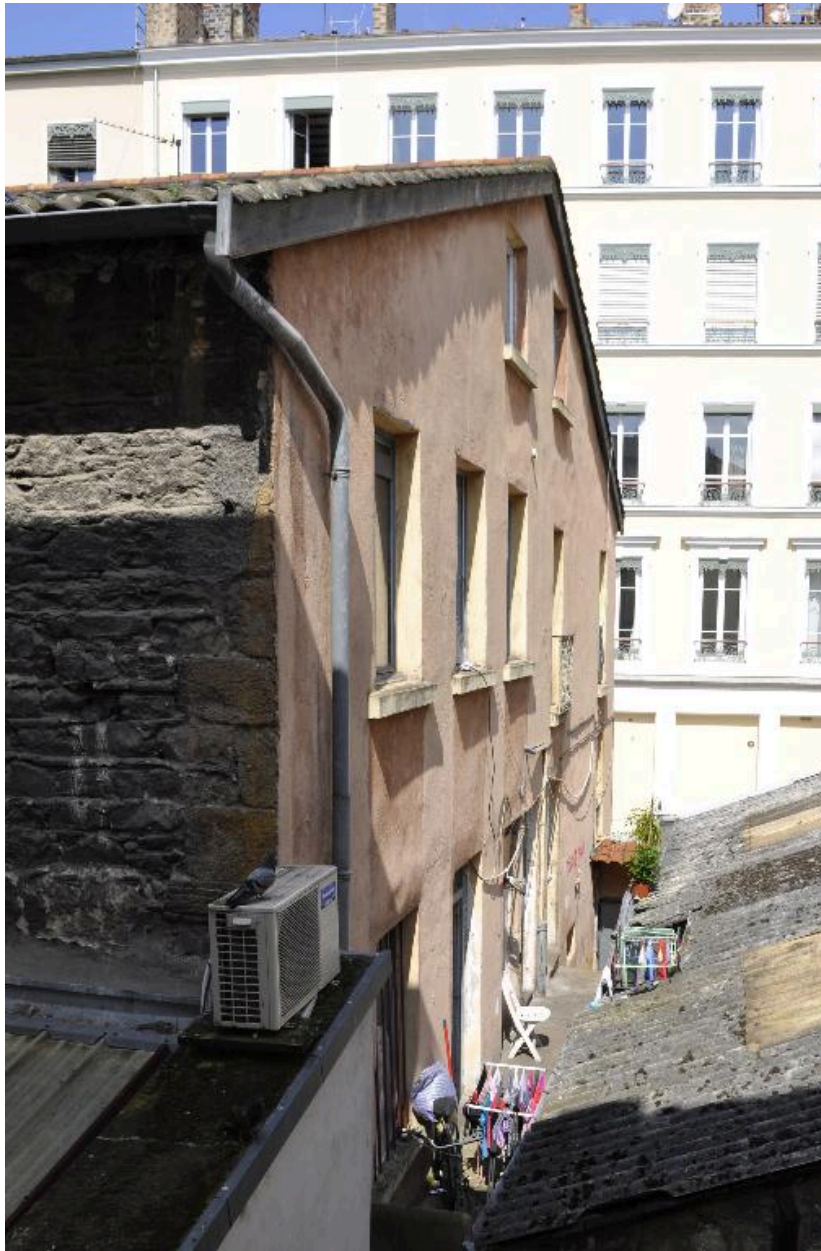
Vue partielle de la façade nord, moellons apparents sur la façade postérieure
