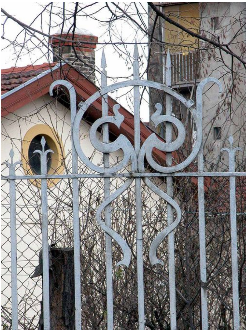
Clôture du jardin, détail de la grille sur la rue Pierre-Delore
