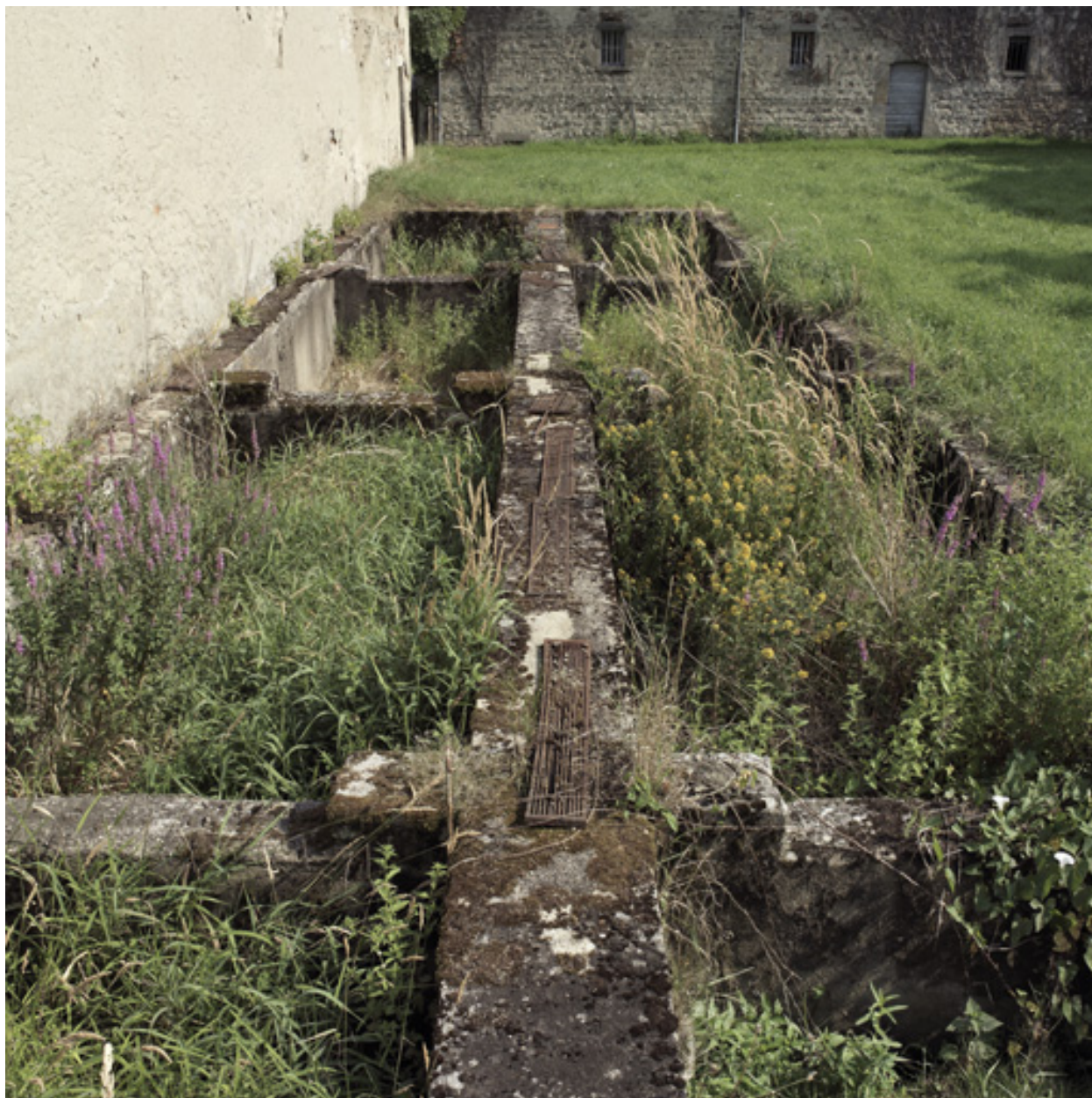
Vue d'ensemble des serves depuis le nord.
