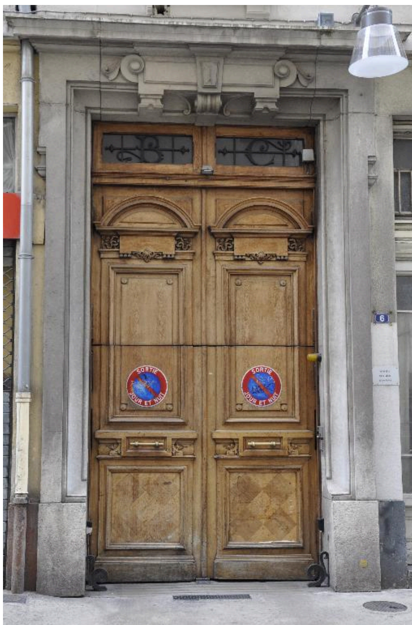
Vue rapprochée de la porte d'entrée
