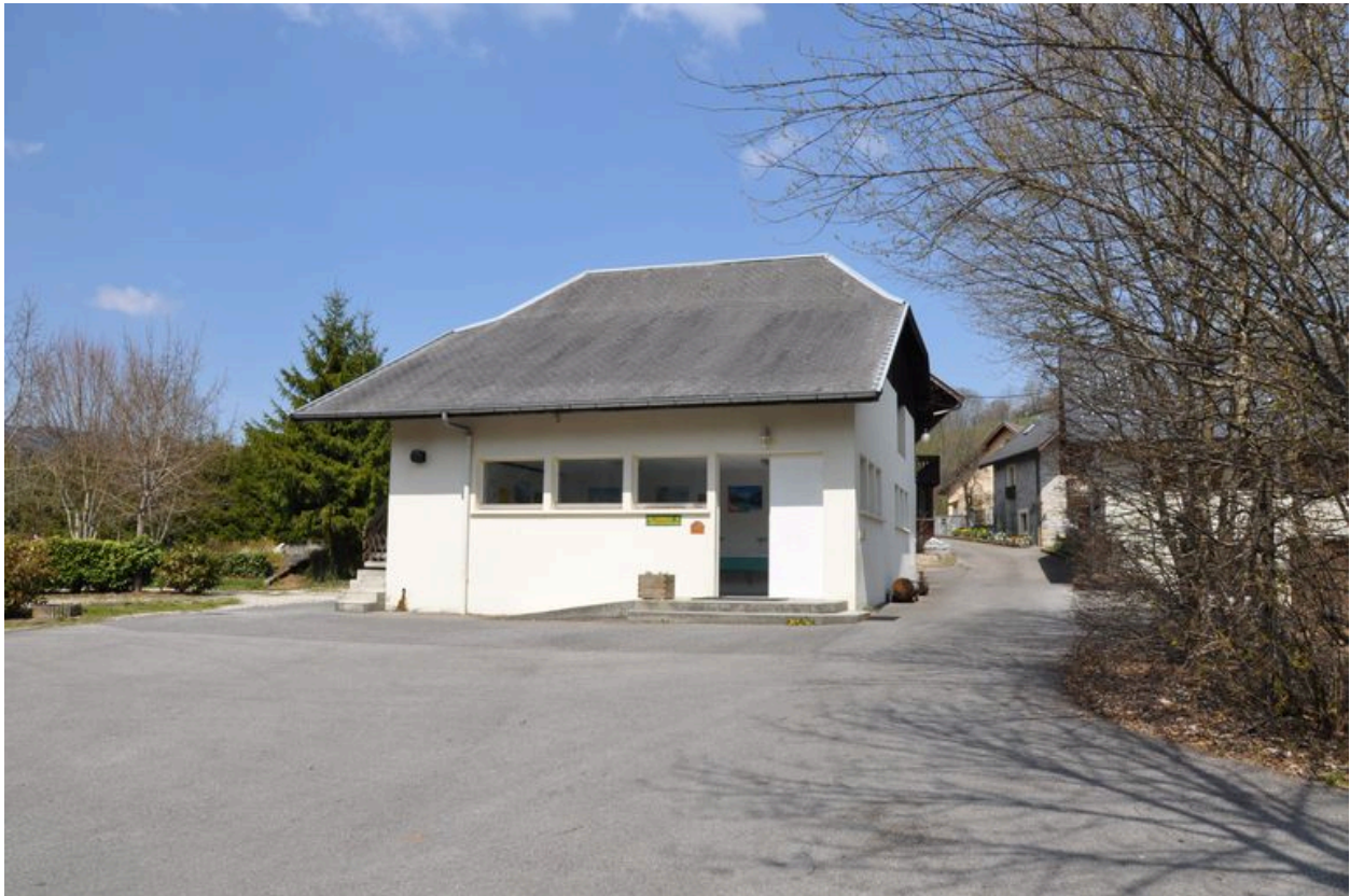
Bâtiment des douches du camping du Moulin Dolay
