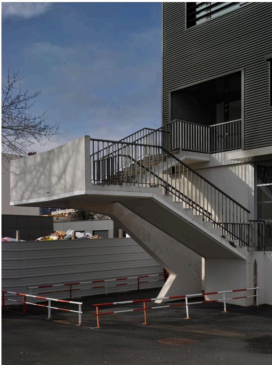
Escalier extérieur au sud du bâtiment B.
