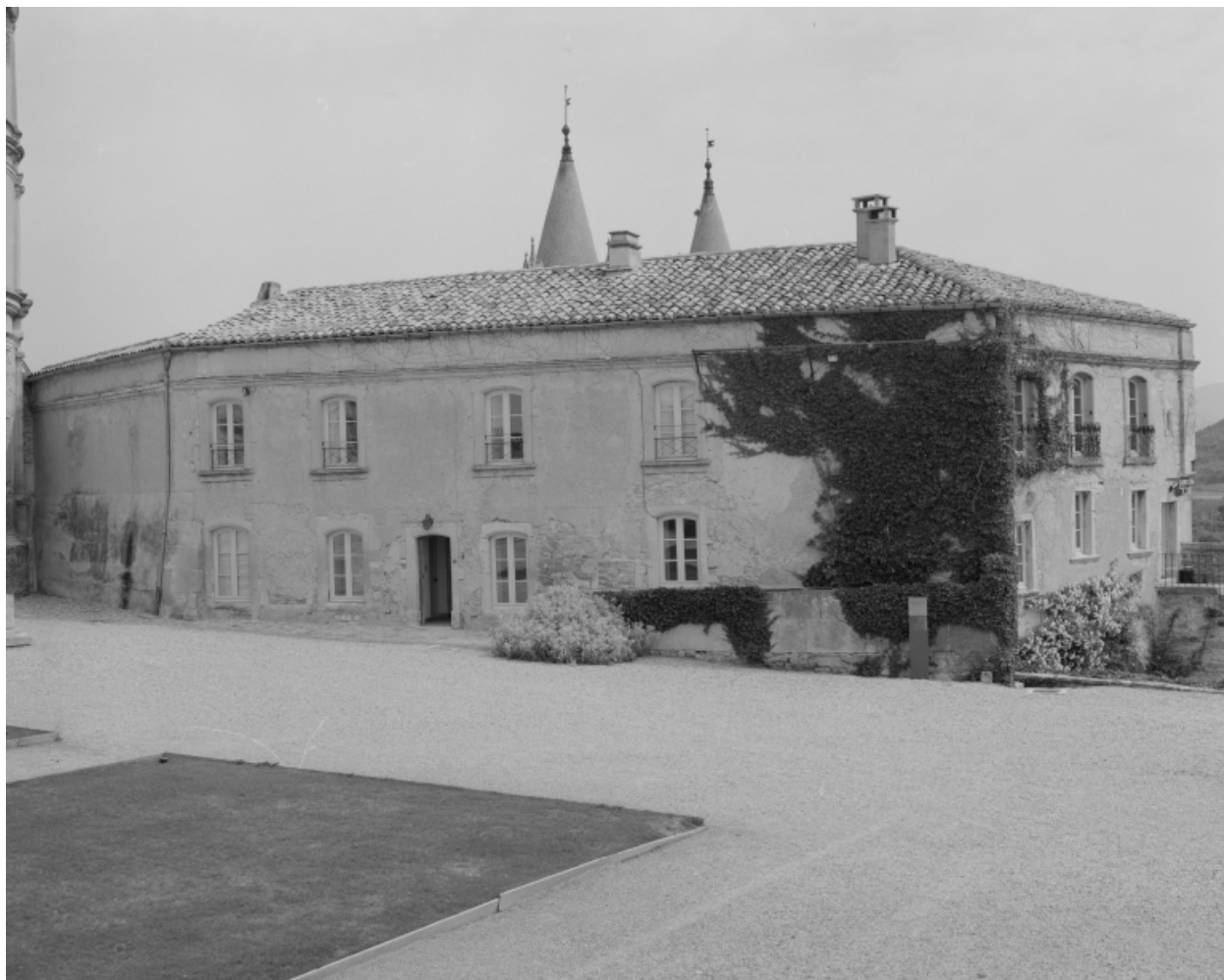
Bâtiment d'entrée. Façade ouest.
