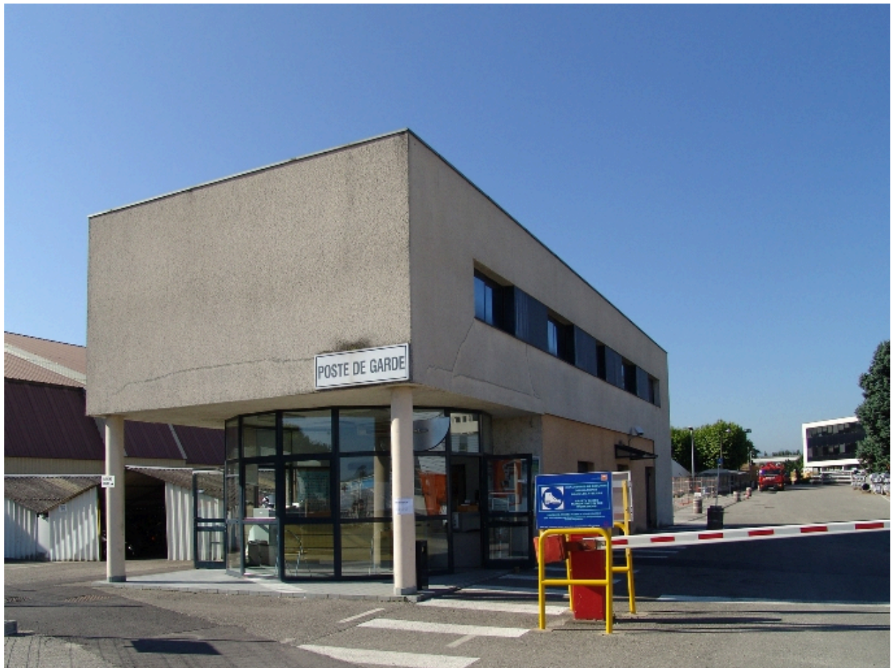
Le poste de garde
