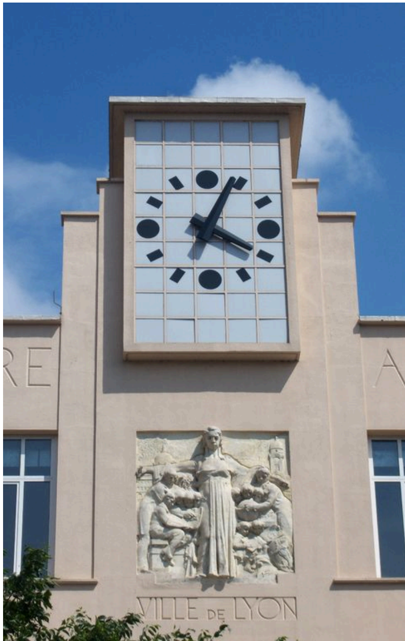
Détail de la façade sur rue, horloge et sculpture
