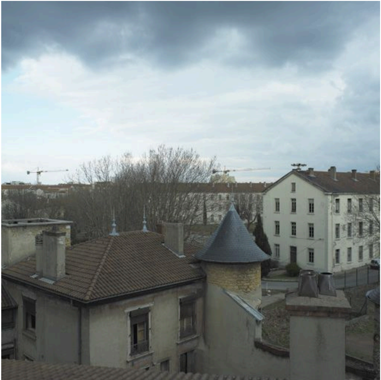
Corps de bâtiment et tour est. Vue des toits depuis le sud-ouest
