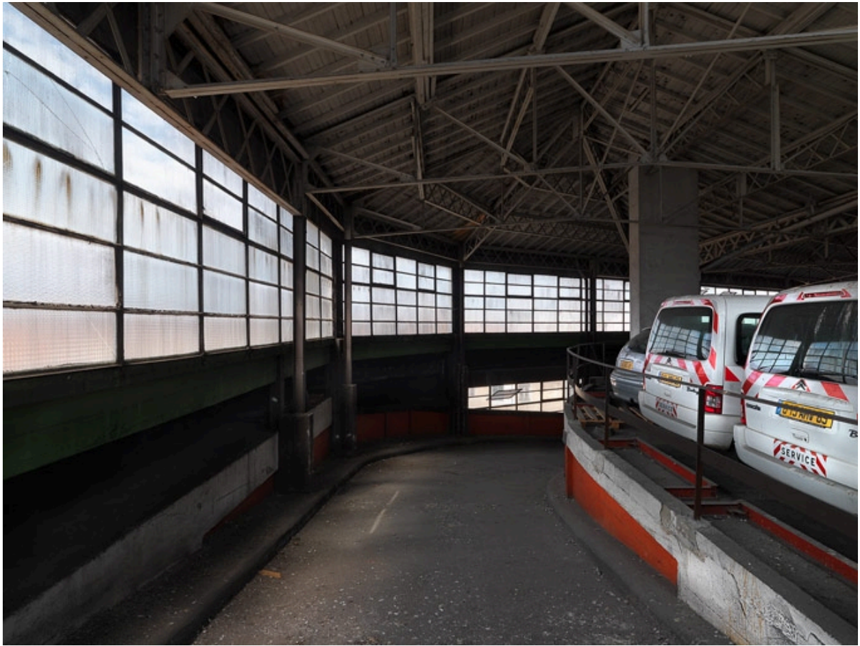
Départ de la rampe descendante du 5e étage
