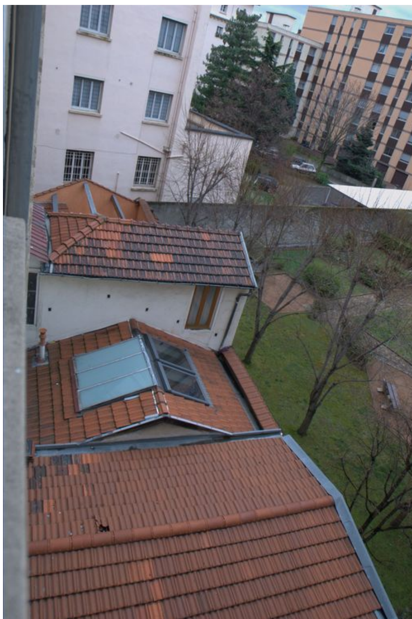
Bâtiments annexes, toitures
