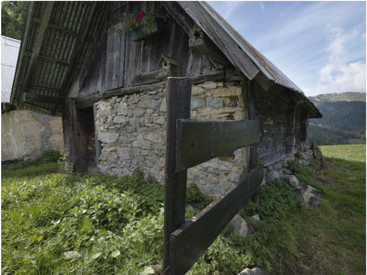
Vue de trois-quarts du bâtiment nord.
