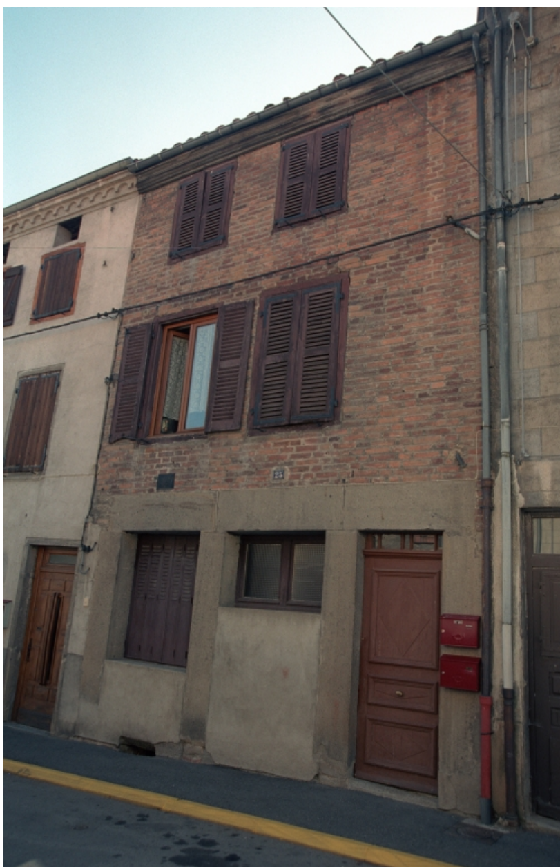
Boën, îlot 15, Gustave Labrosse (rue) 25. Vue générale de la façade sur rue.
