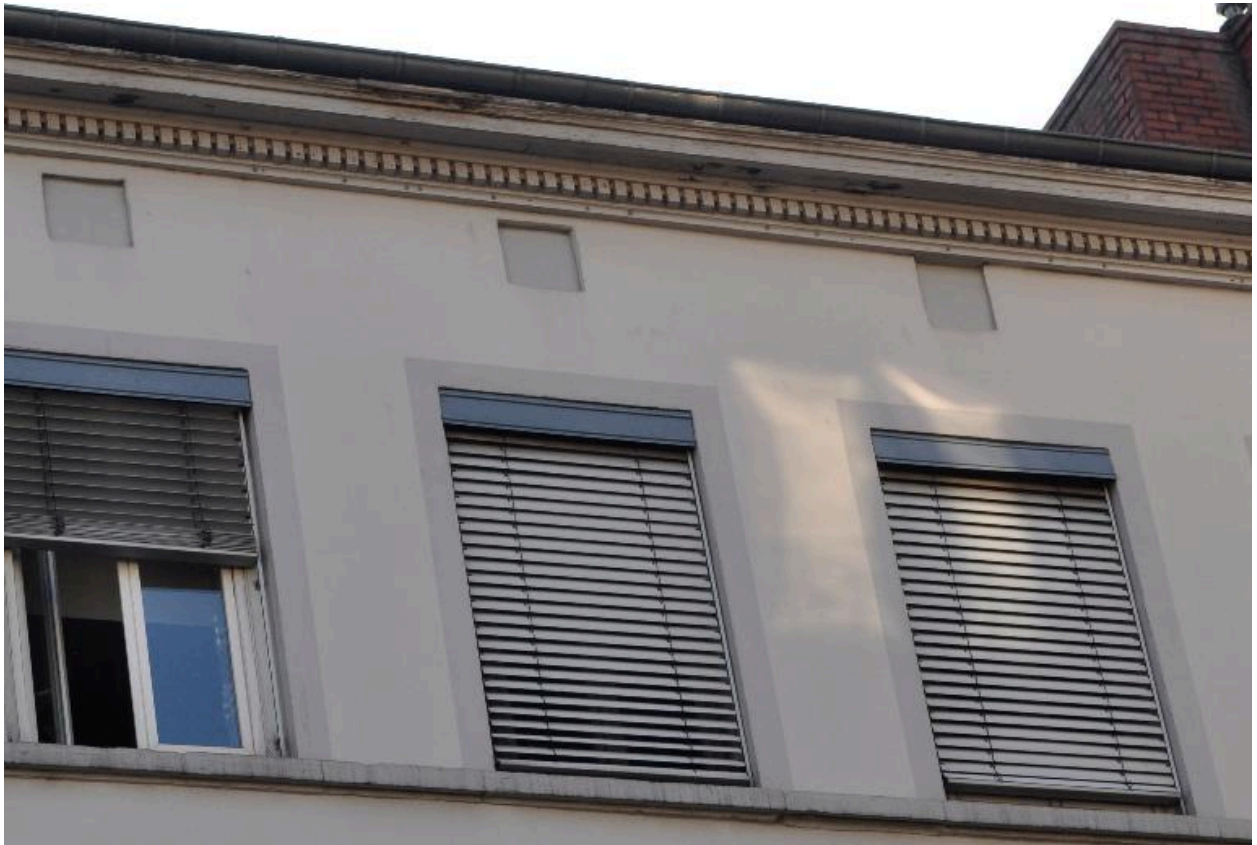
Élévation sur rue, détail du surcroît et corniche
