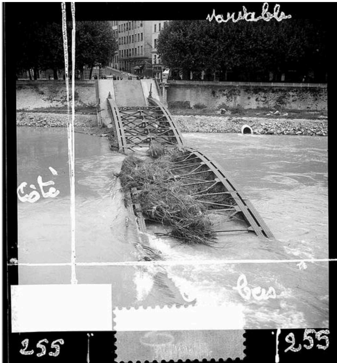
Le pont de la Boucle détruit par l'armée allemande. Septembre 1944. 1 fotogr. : n. et b. (AM Lyon 3 Ph 195)
