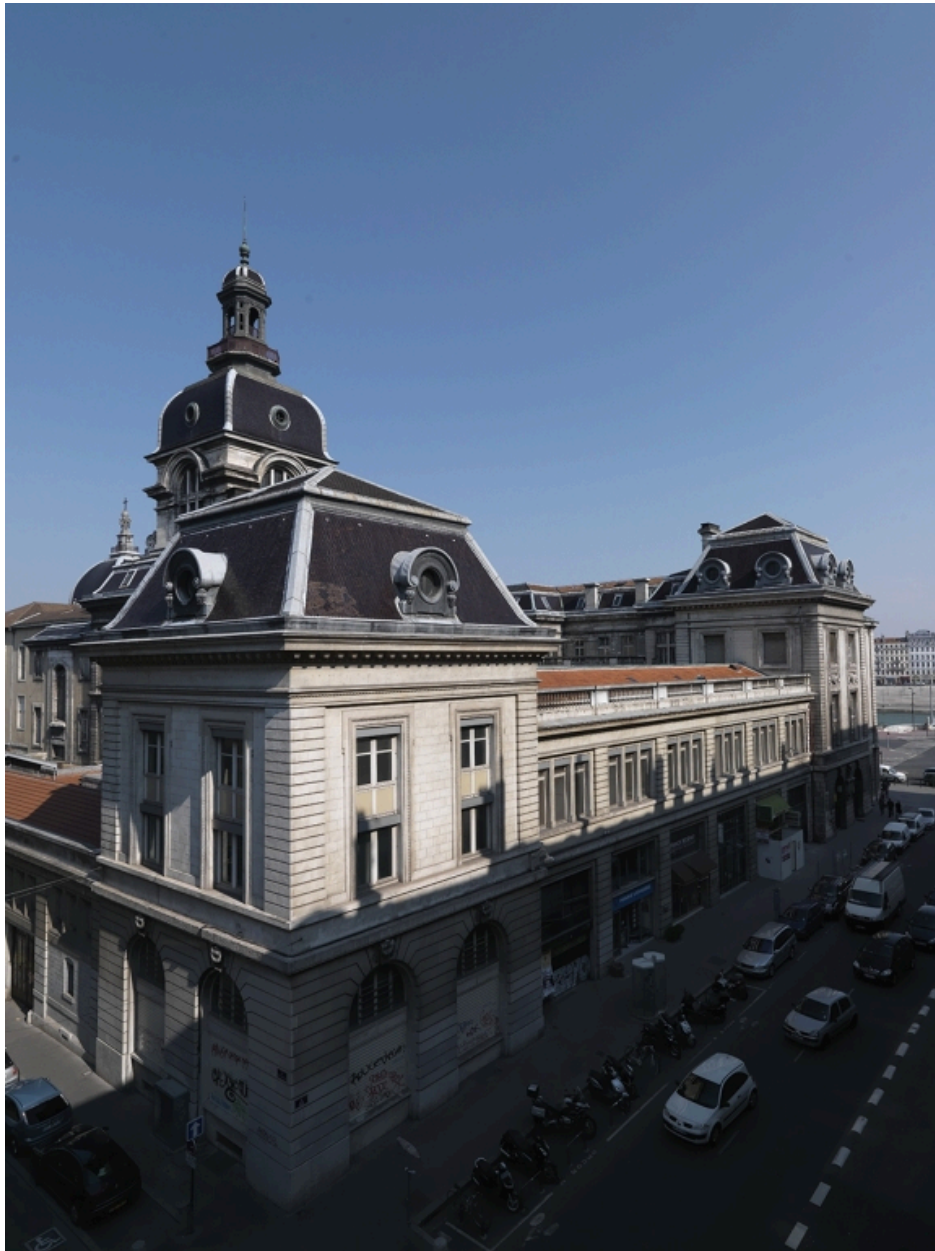
Bâtiment A'. Vue d'ensemble depuis le sud-ouest
