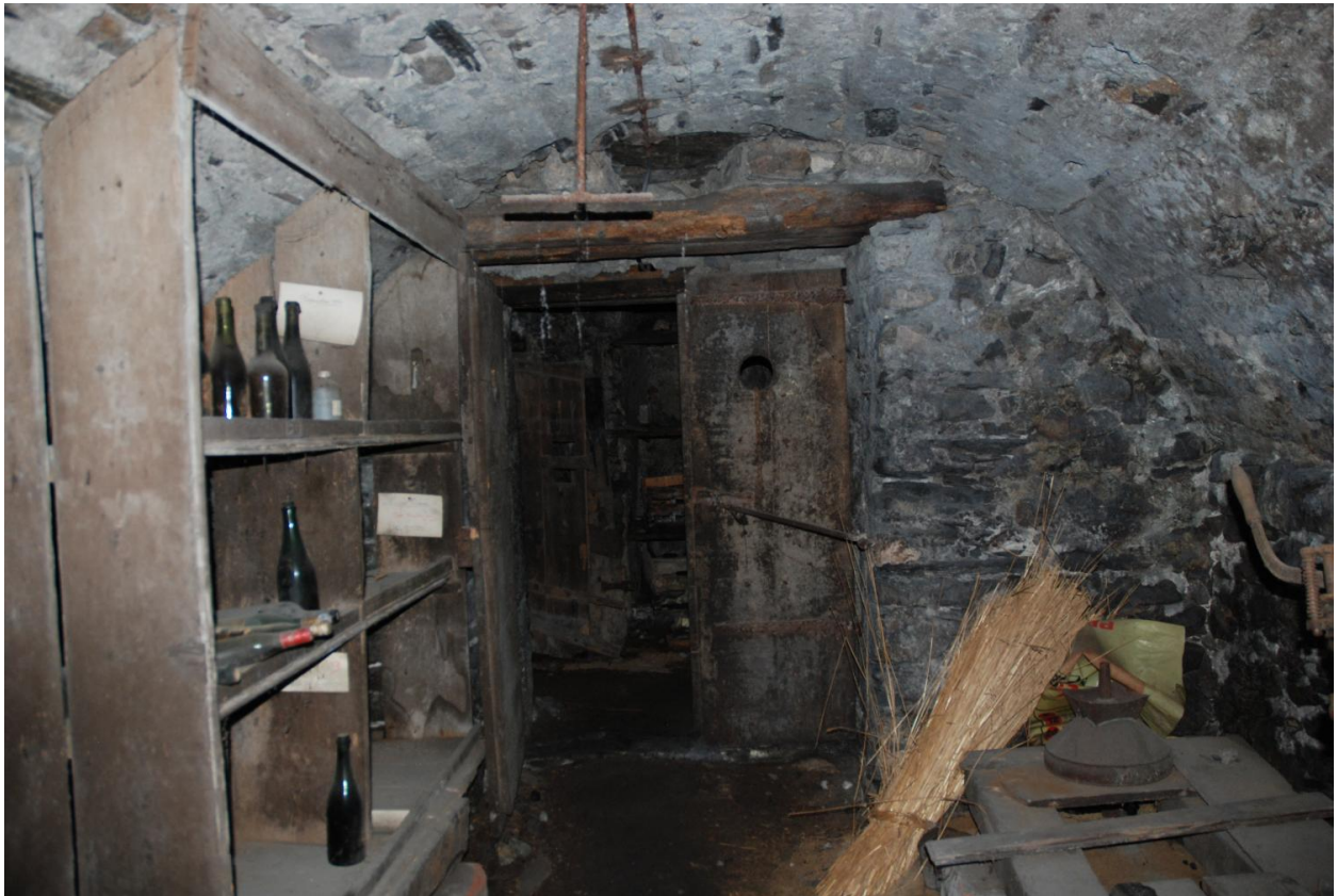
Vue intérieure du sous-sol : cave médiane, vue vers la porte.
