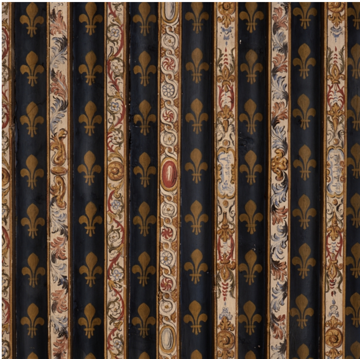
Solives, 2e travée, centre, détail.
