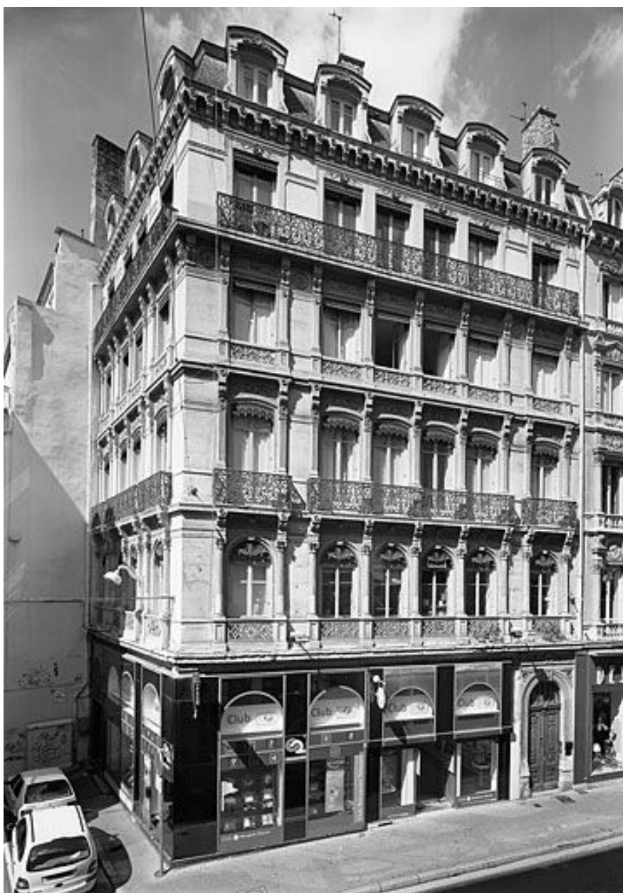
Vue générale des façades
