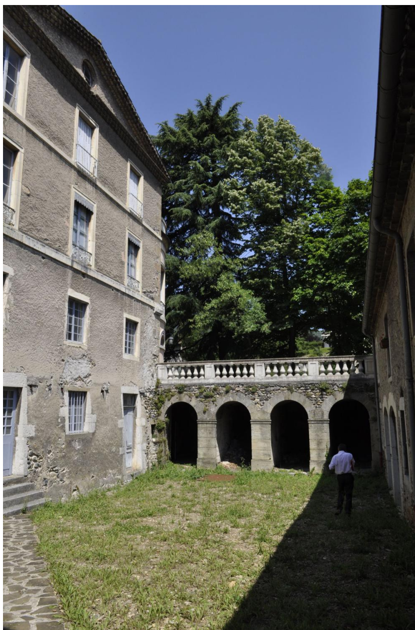
Vue des extérieurs, galerie
