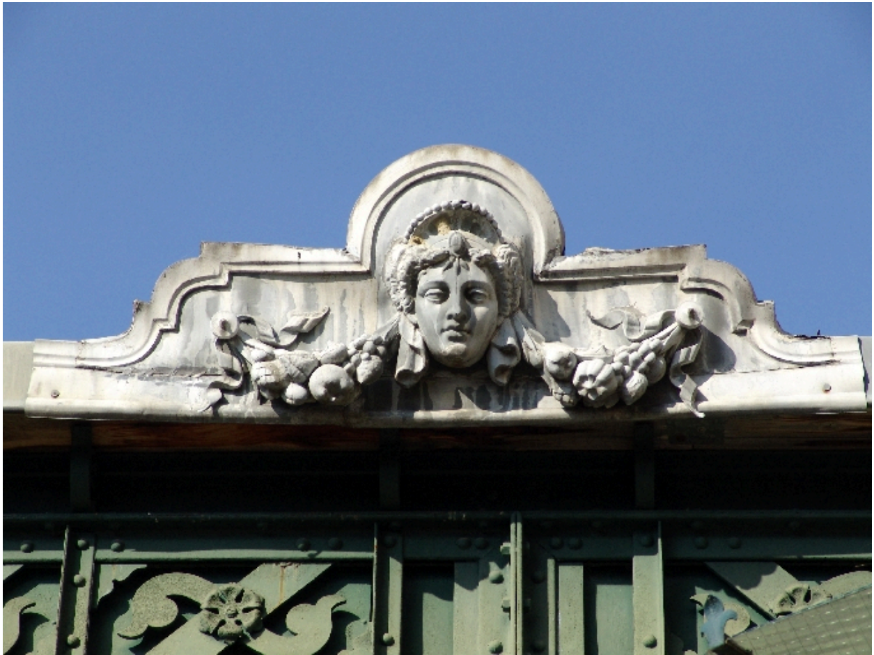
Détail d'un motif de couronnement, galerie nord sur terrasse
