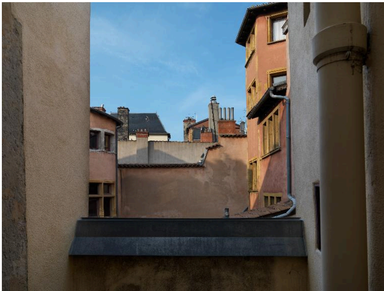
La cour : partie supérieure des cages d'escalier depuis la commanderie des Antonins
