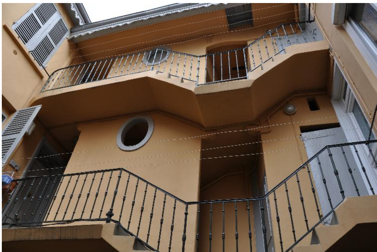
Vue de l'escalier depuis la cour
