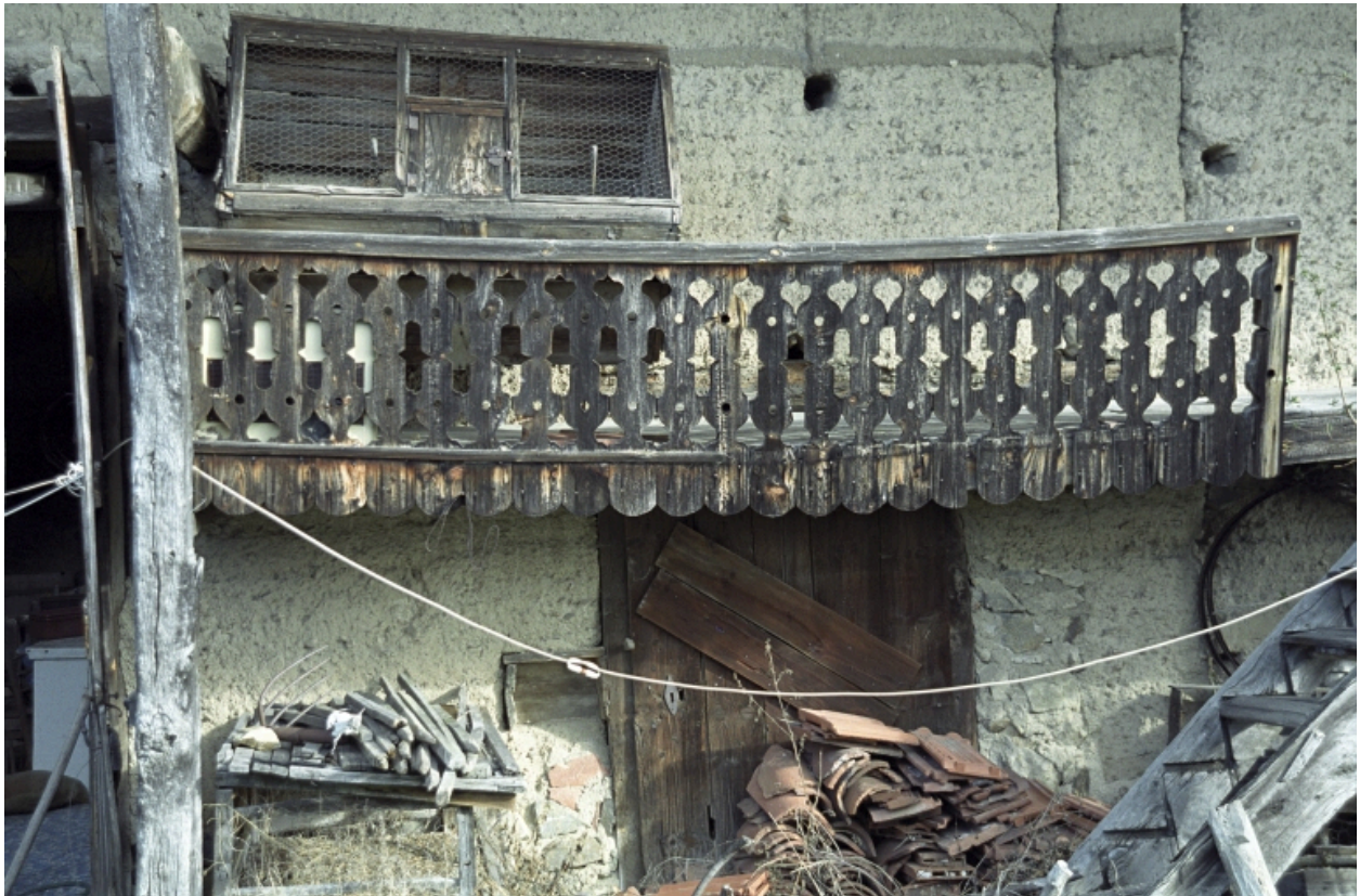
Vue de la galerie située devant la grange-étable.
