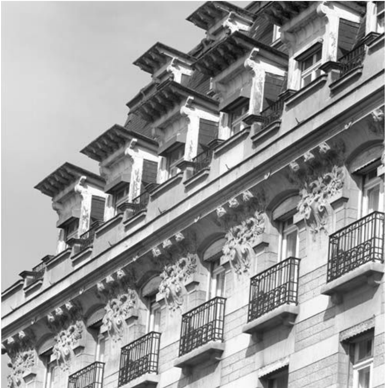
Détail du dernier étage carré et des étages de comble
