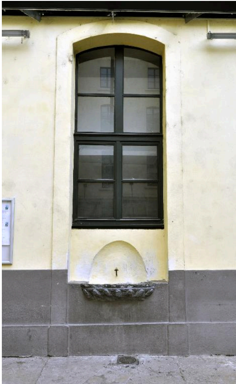
Cour, élévation est, baie du rez-de-chaussée
