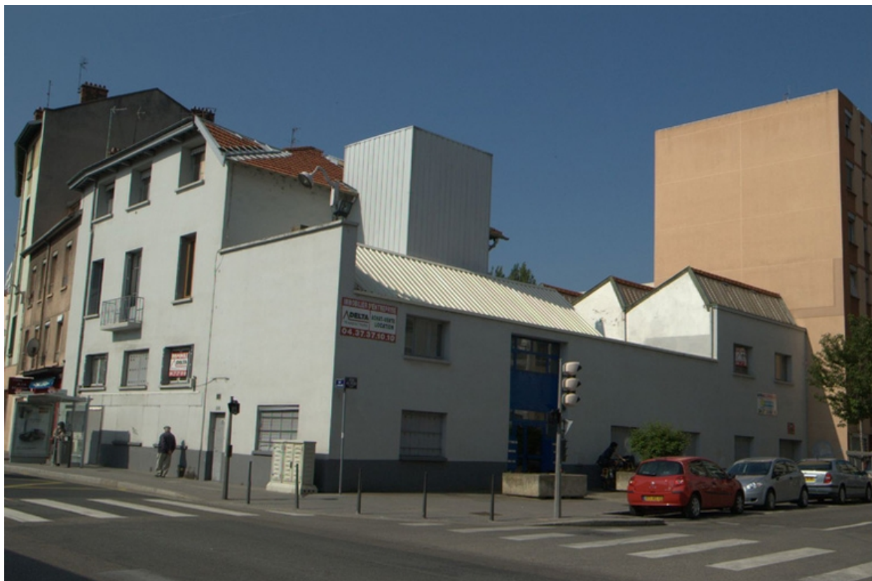
Vue générale nord-est
