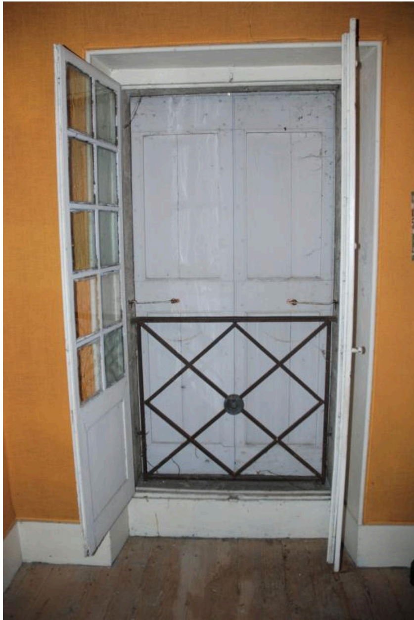
Corps principal, premier étage, partie nord, chambre (Cf. Plan étage 1), détail de la fenêtre avec garde-corps en fer forgé.
