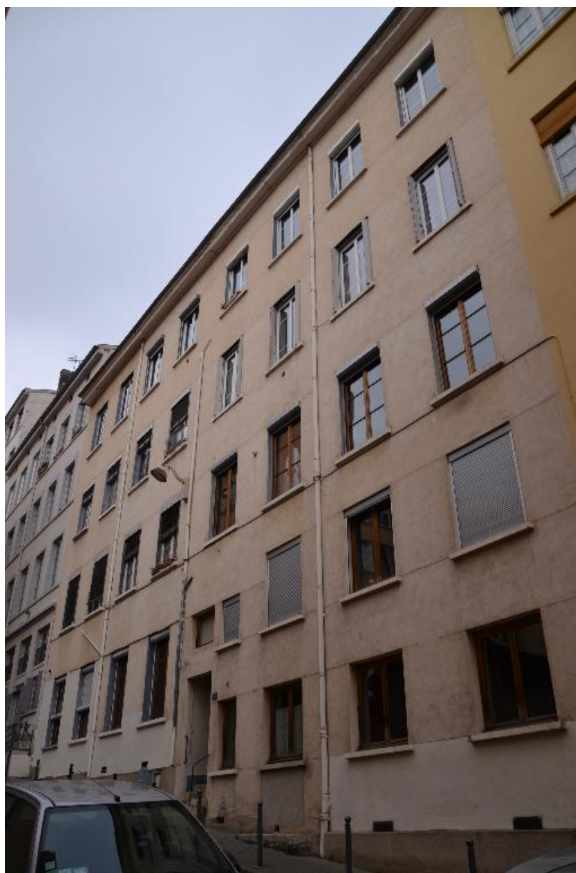
Vue d'ensemble façade sud
