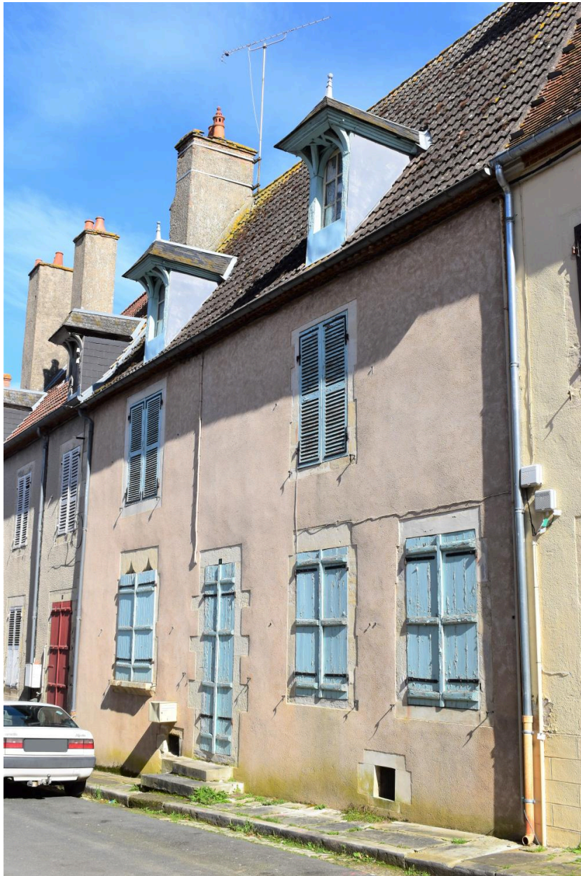
Vue générale de la façade de la maison du 4, rue d'Allier, parcelle cadastrale B01 : 58.
