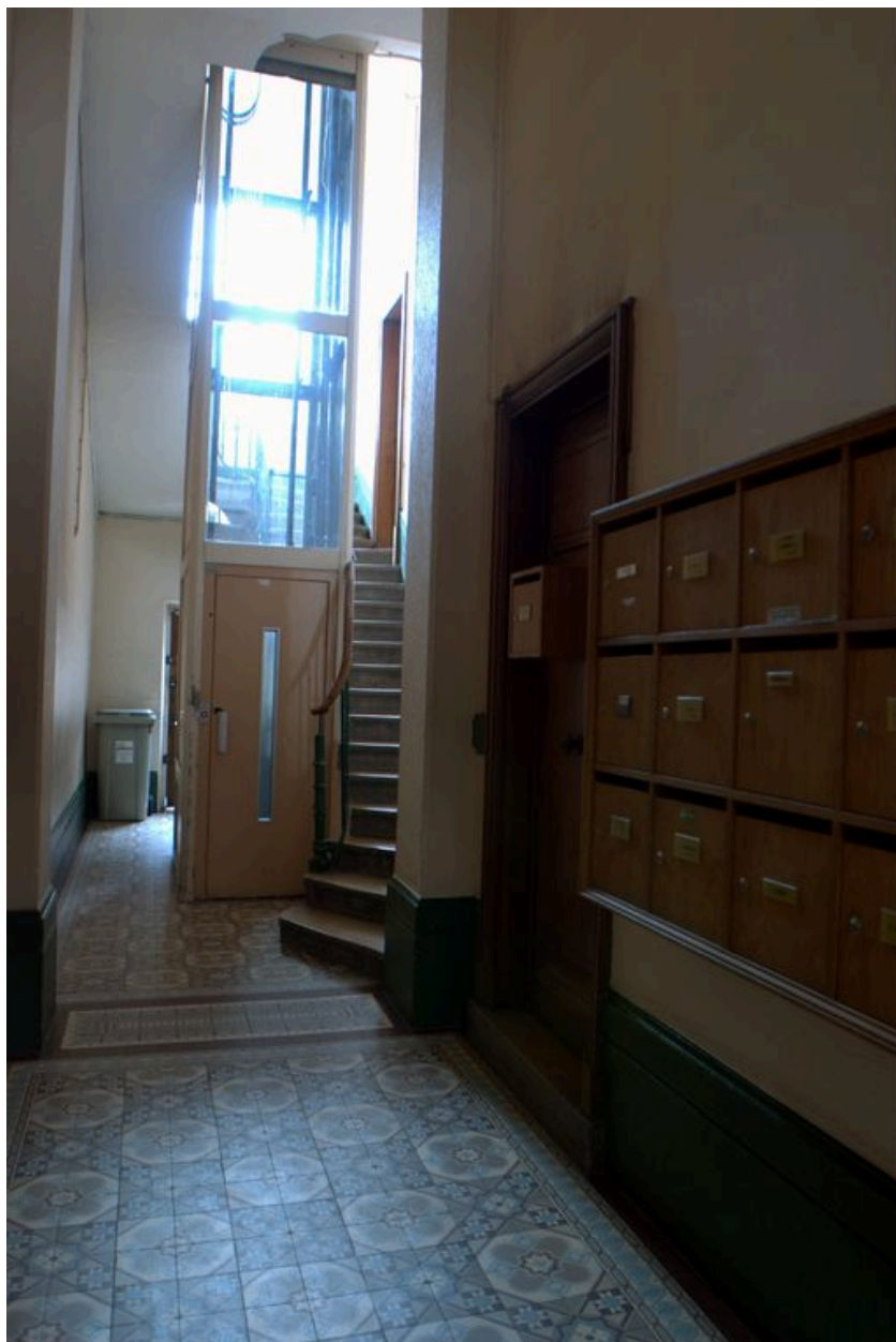
Vestibule et 1ère volée de l'escalier
