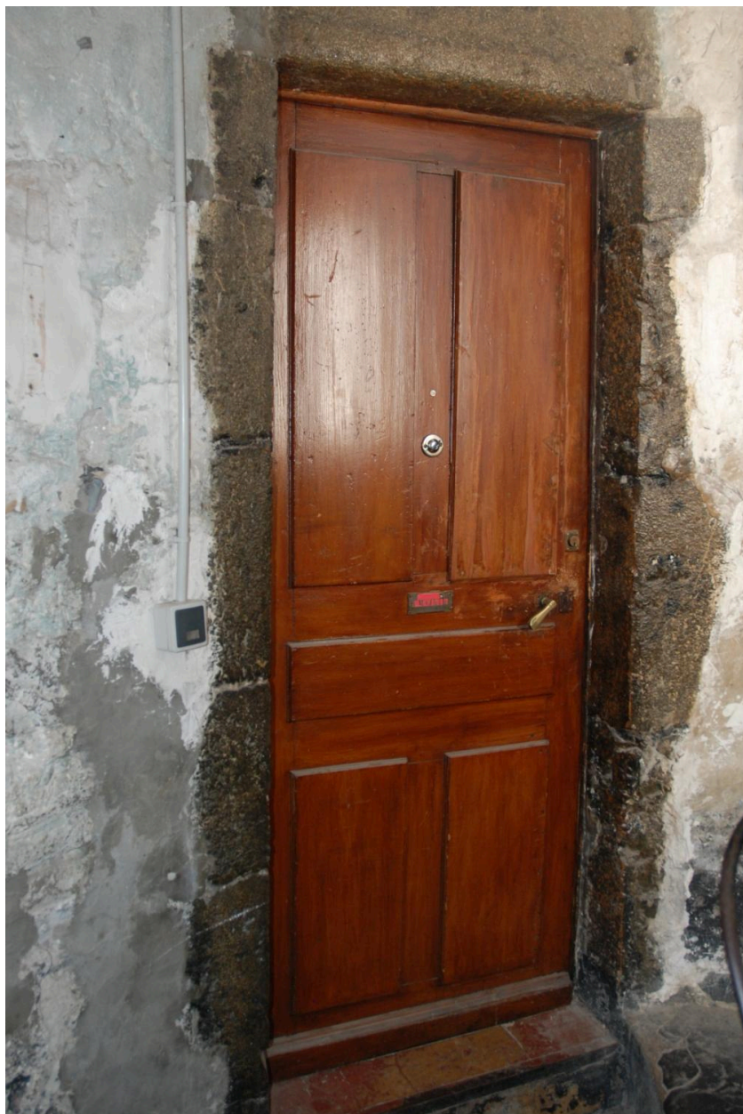
Maison, immeuble, place Charles-Albert (2018 E1 1796). Vue intérieure, porte donnant sur l'escalier en vis.
