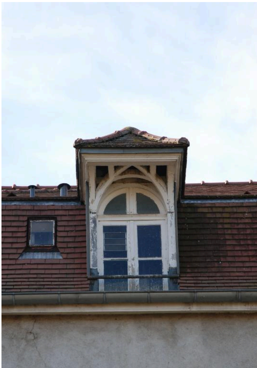
Château, élévation est : détail d'une lucarne
