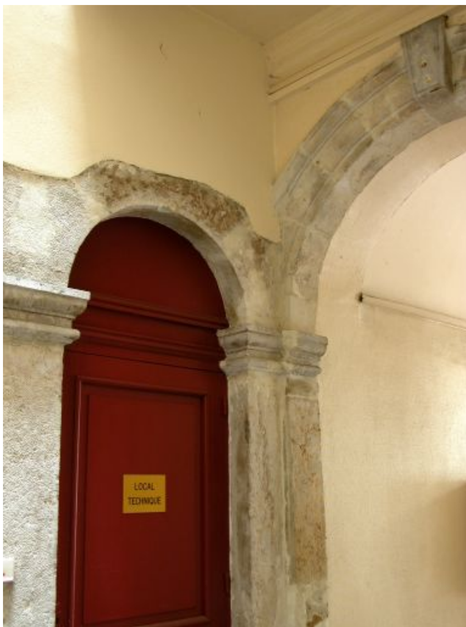
Cour, débouché de l'allée et porte de l'aile ouest
