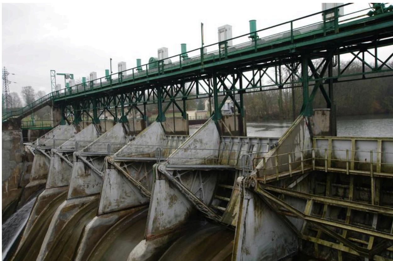
Le barrage mobile constitué d'une série de vannes du type semi-cylindriques
