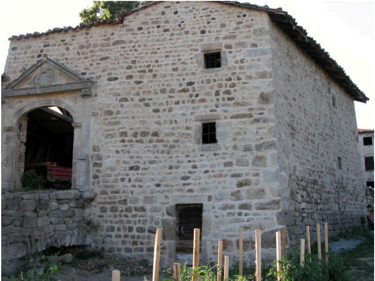
Corps de bâtiment situé au sud du portail d'entrée.
