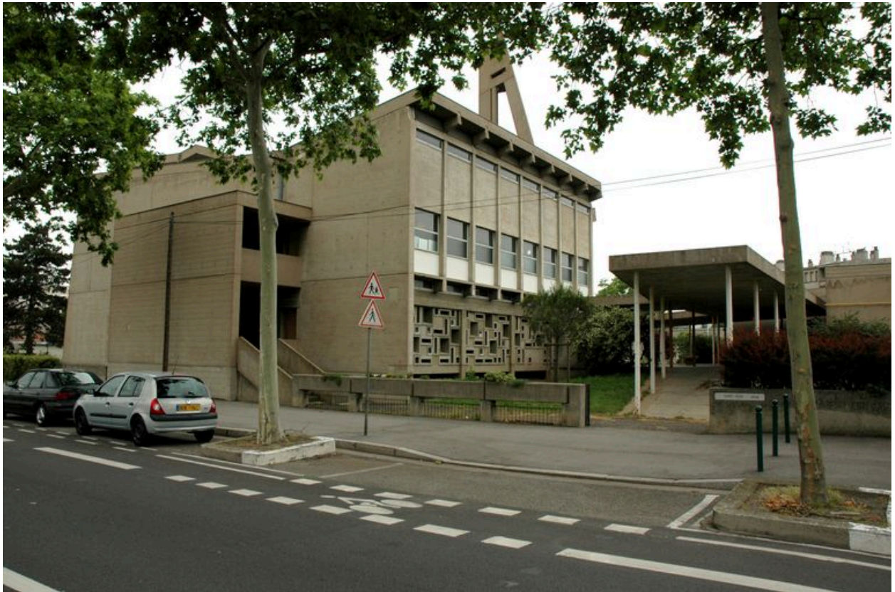
Vue générale depuis le sud-est
