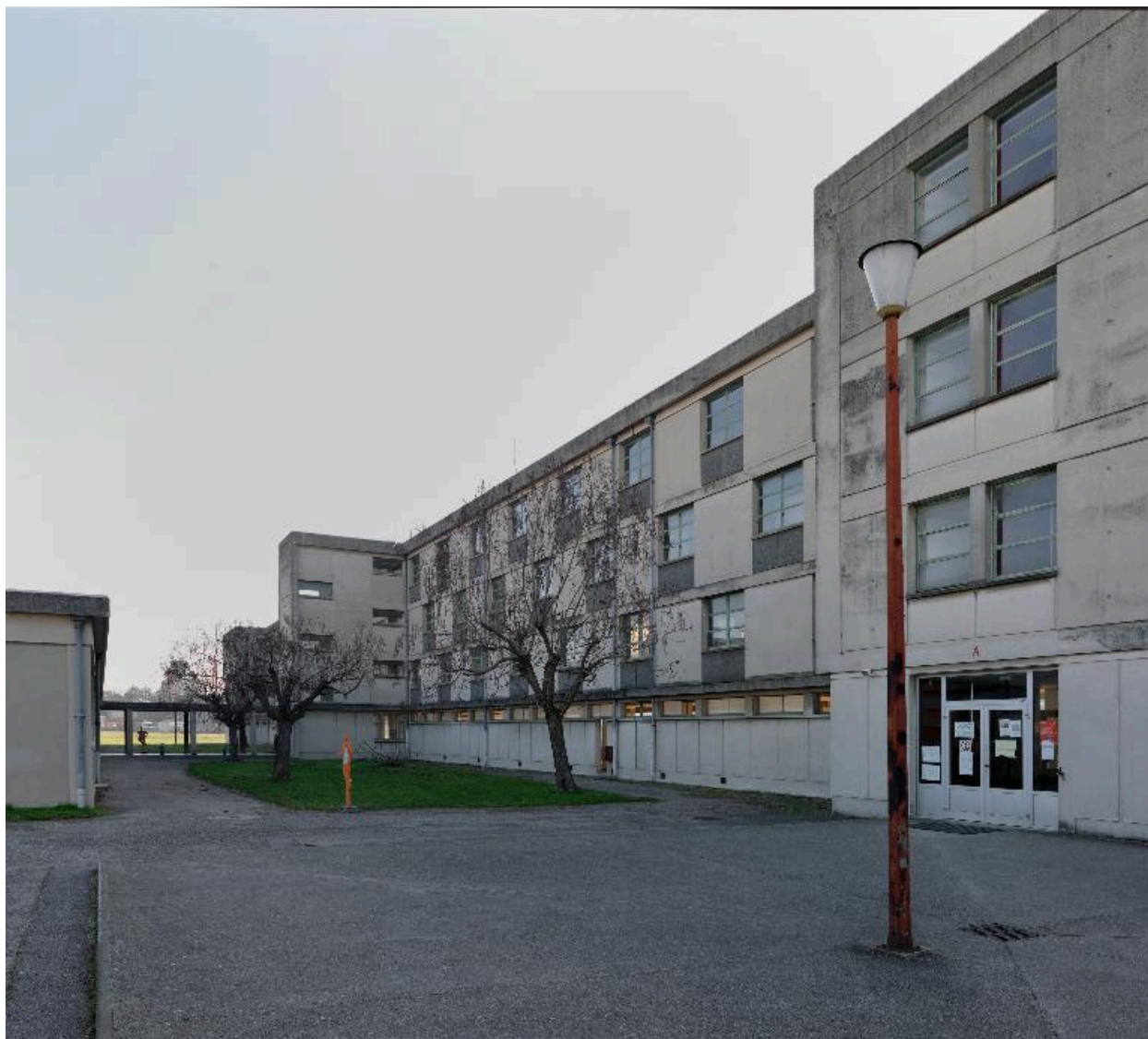
Externat, élévation postérieure
