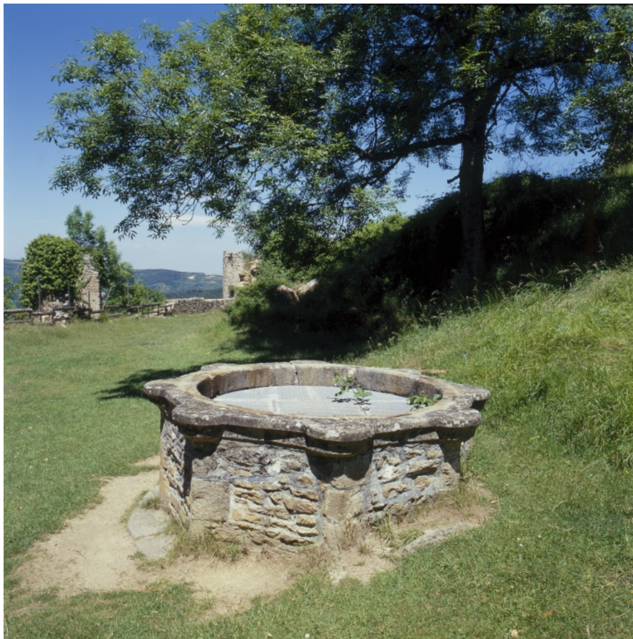
Premier baile : vue intérieure de la partie nord-ouest de la première enceinte et détail du puits, du sud-ouest.
