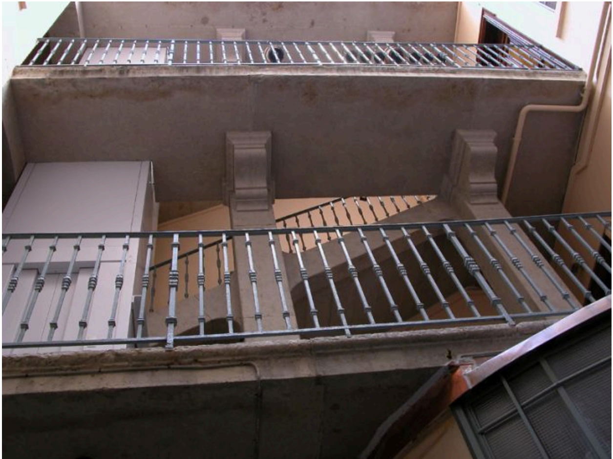
Escalier et coursières vus par-dessous
