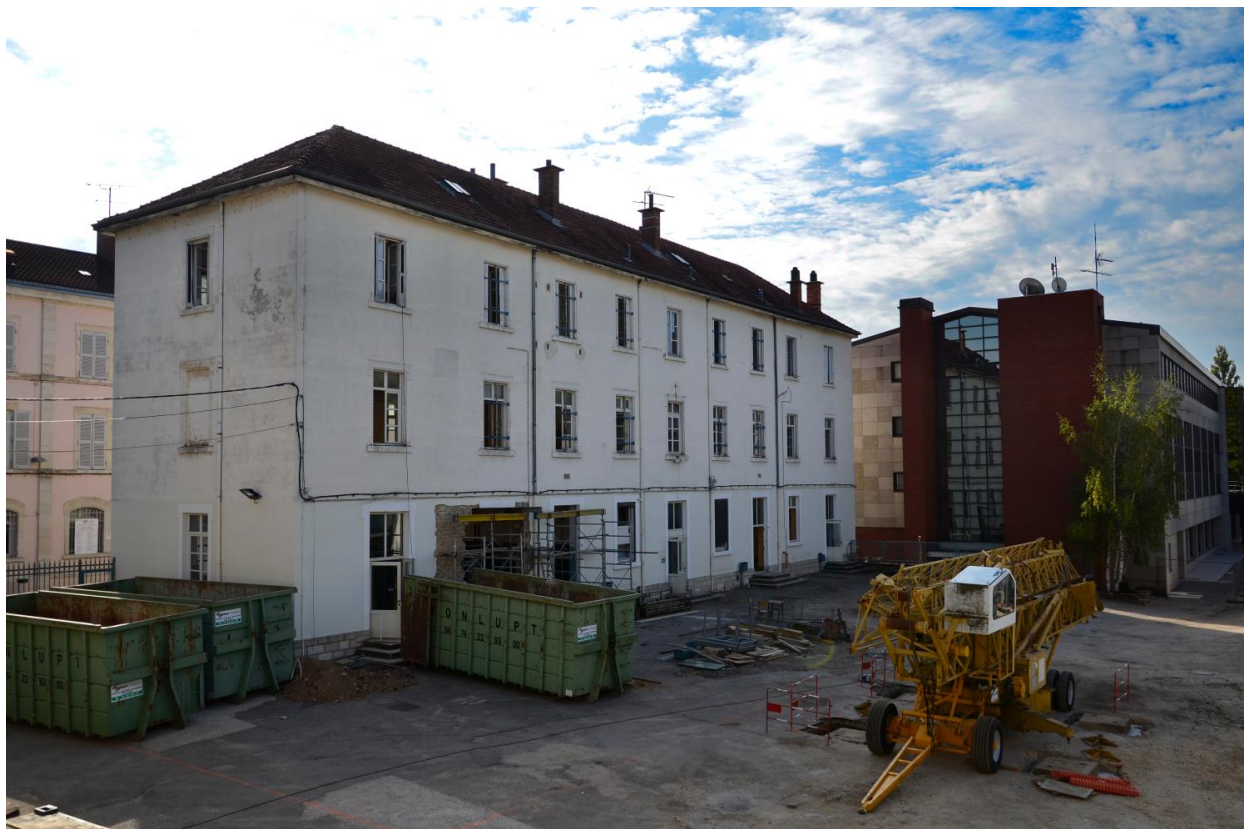
Petit lycée v. 1996, en cours de restructuration (Phot. M. Poncin, A Lycée Lalande)
