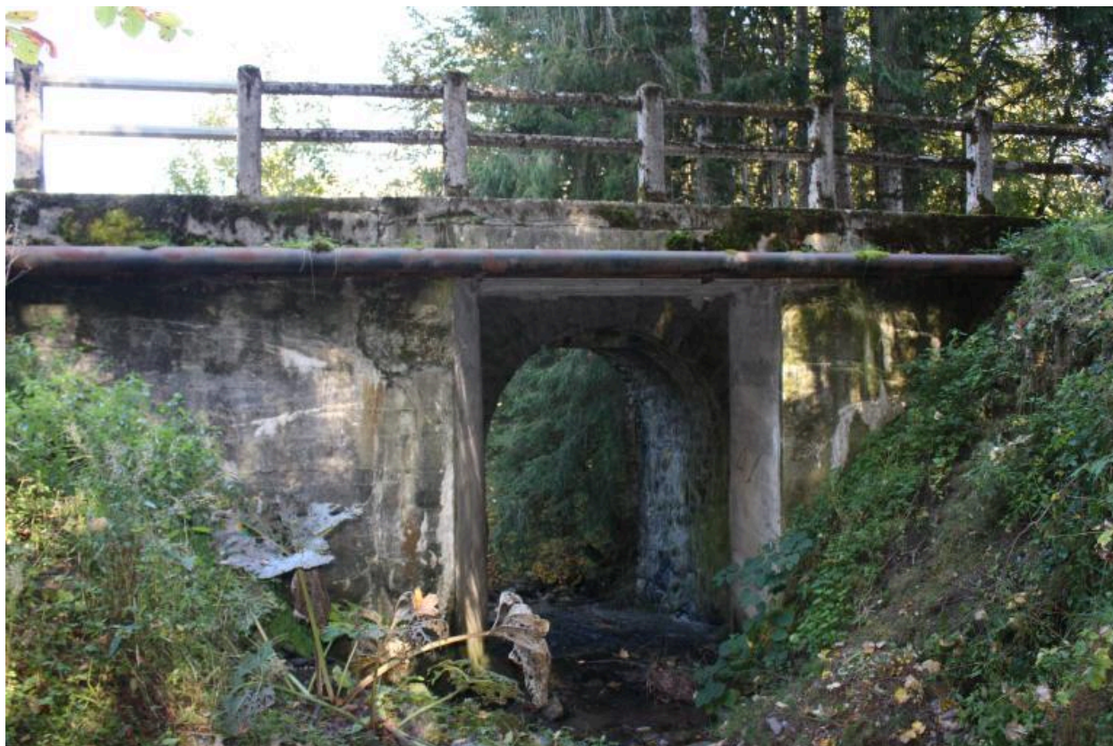
Pont de la route de la Villaz, face amont
