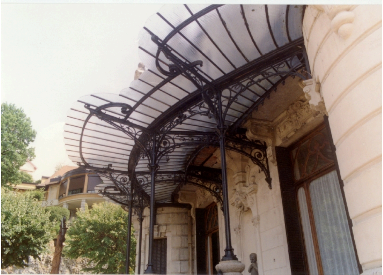
Marquise du perron nord
