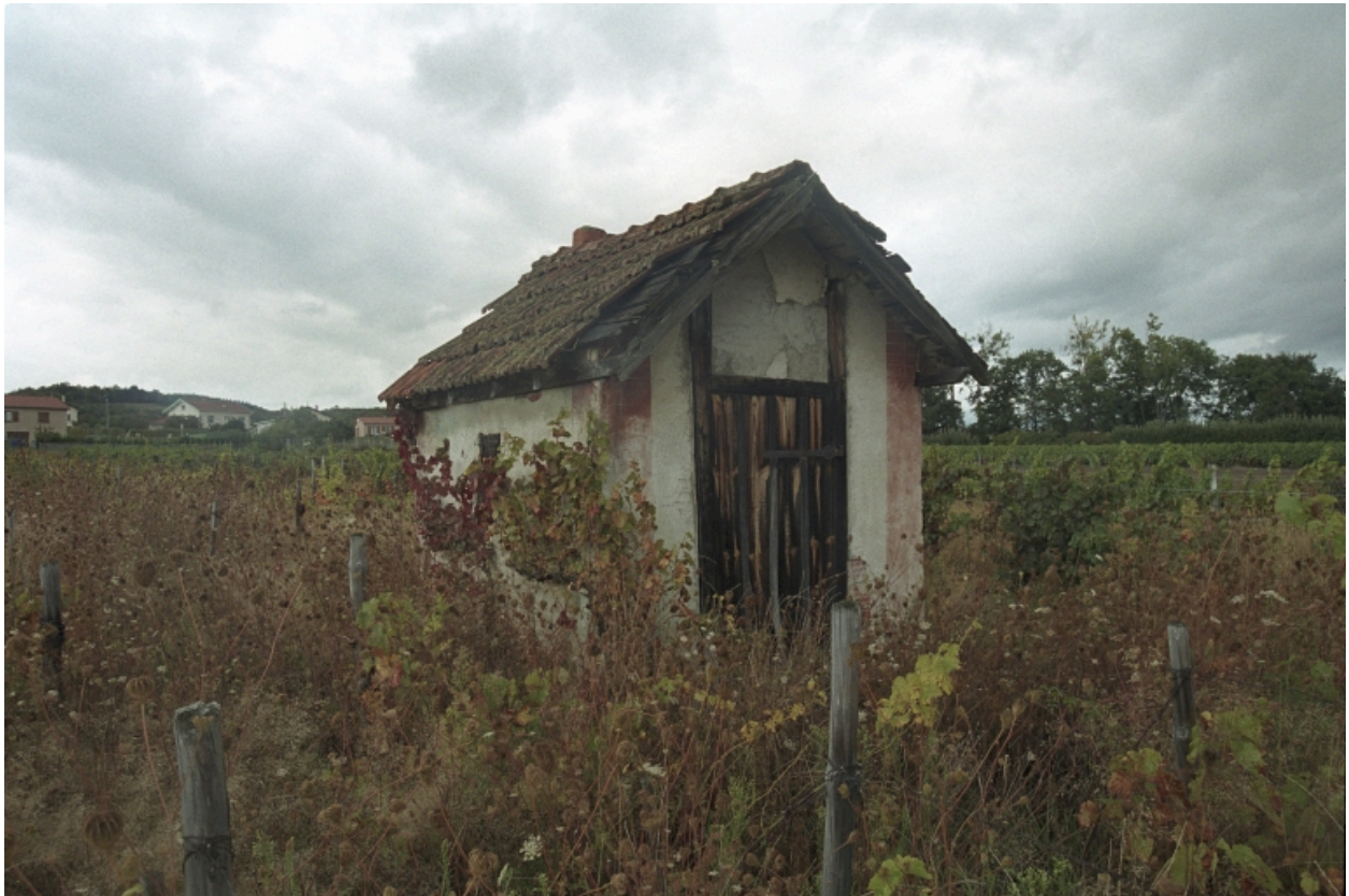
Boën, La Moresse (1986 AC 276). Loge en rez-de-chaussée de type R3a1. Vue d'ensemble.
