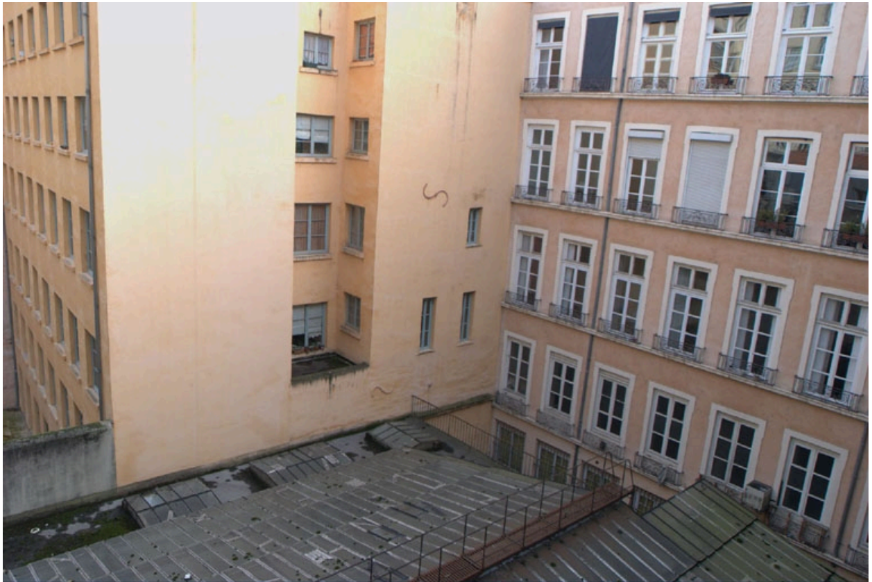
Verrière vue ouest
