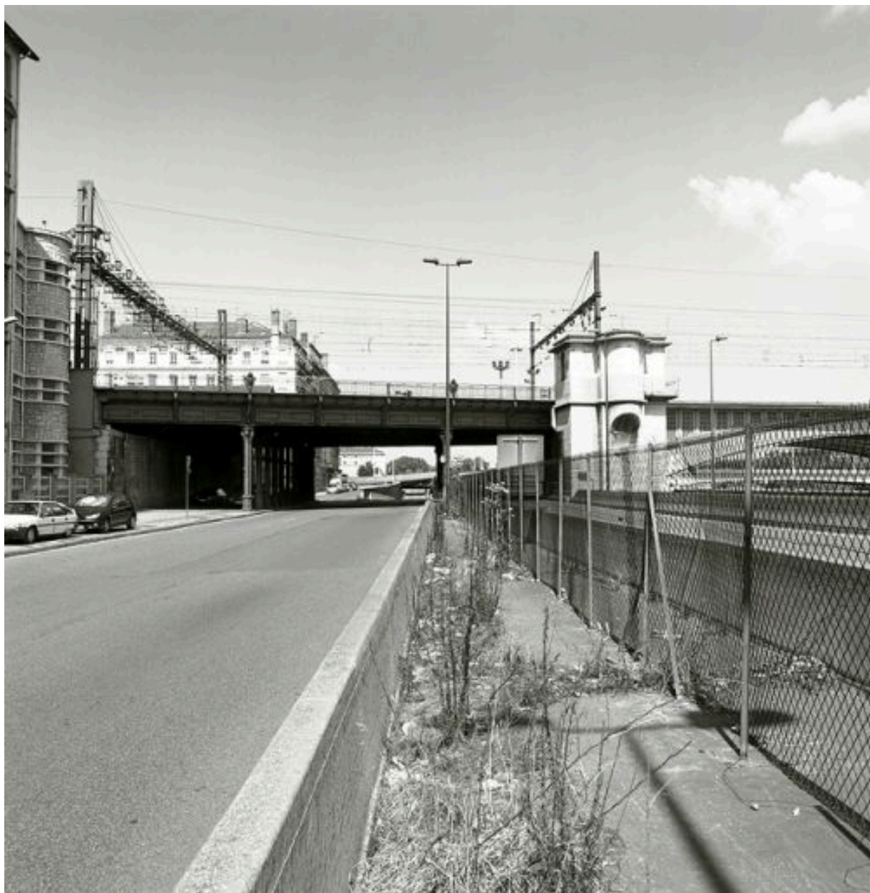
Vue de la travée de rive sur le quai Perrache, depuis le sud
