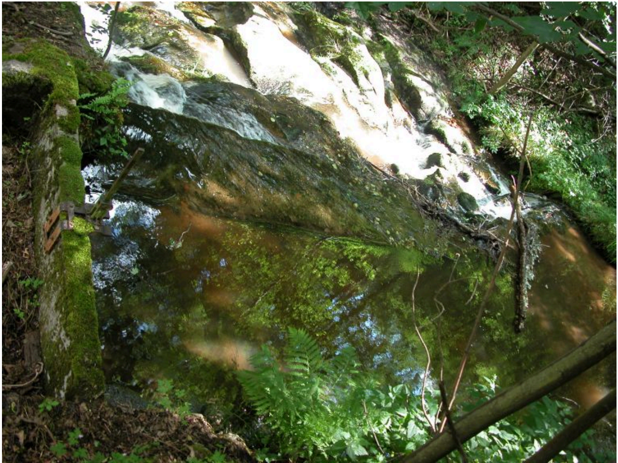
Détail de la vanne de la retenue.
