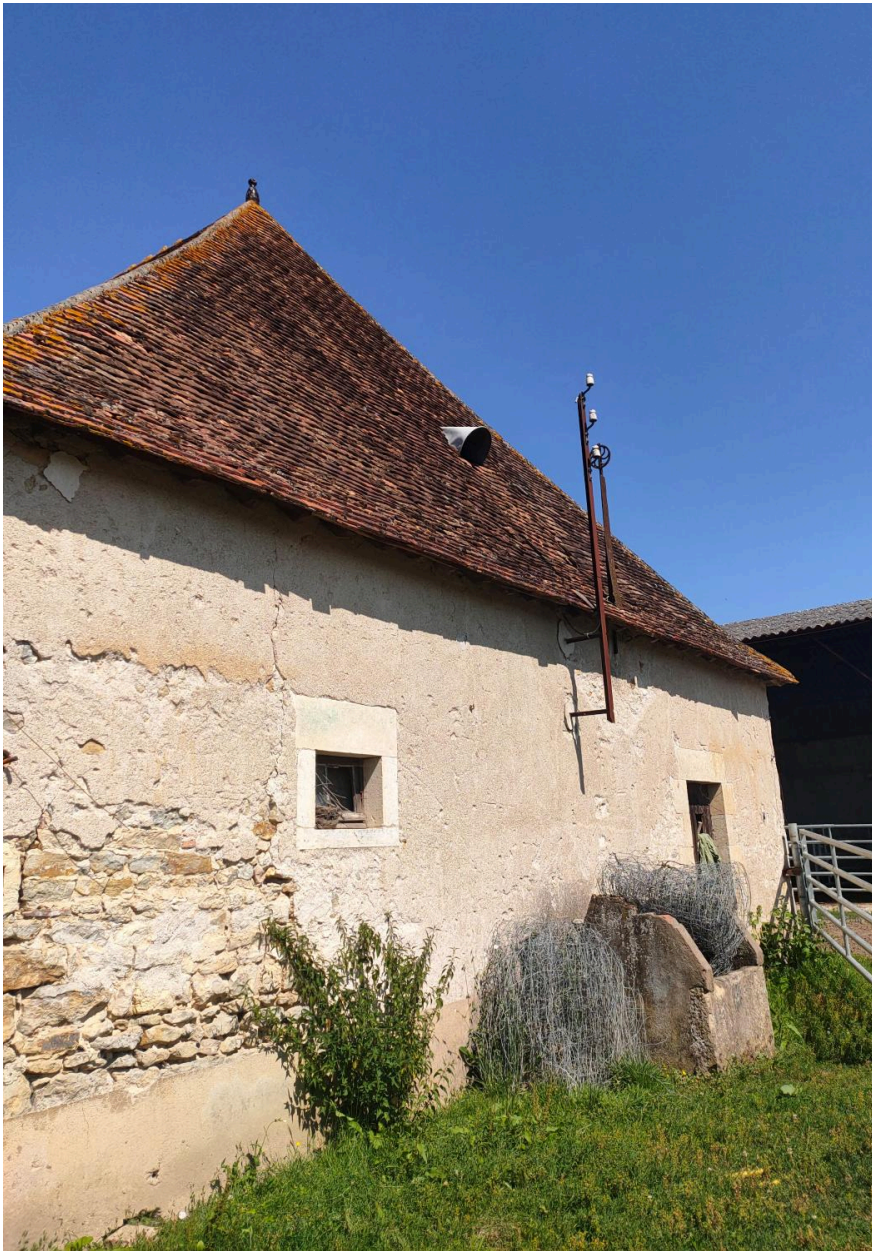
Vue du pignon oriental de la grange.
