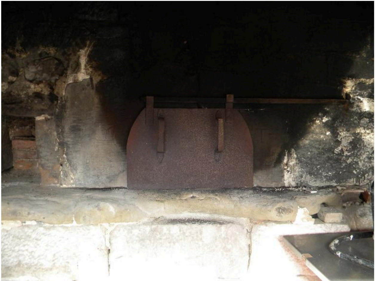
Vue de la bouche du four en molasse.
